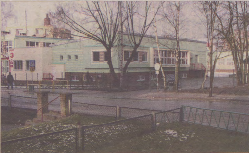
Starogardzki samorząd dba o oświatę, m.in. remontując już istniejące budynki, jak ten - Publicznej Szkoły Podstawowej nr 3.
