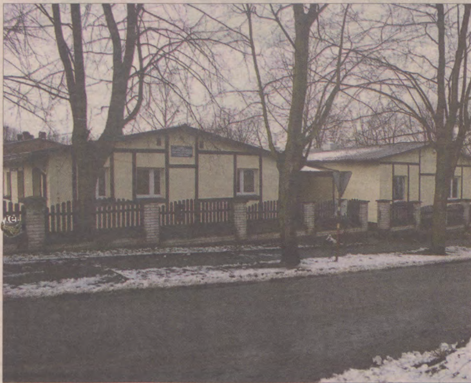
Dzięki rozbudowie praktycznie dwukrotnie zwiększyła się powierzchnia Ośrodka Profilaktyki i Rozwiązywania Problemów Alkoholowych.
