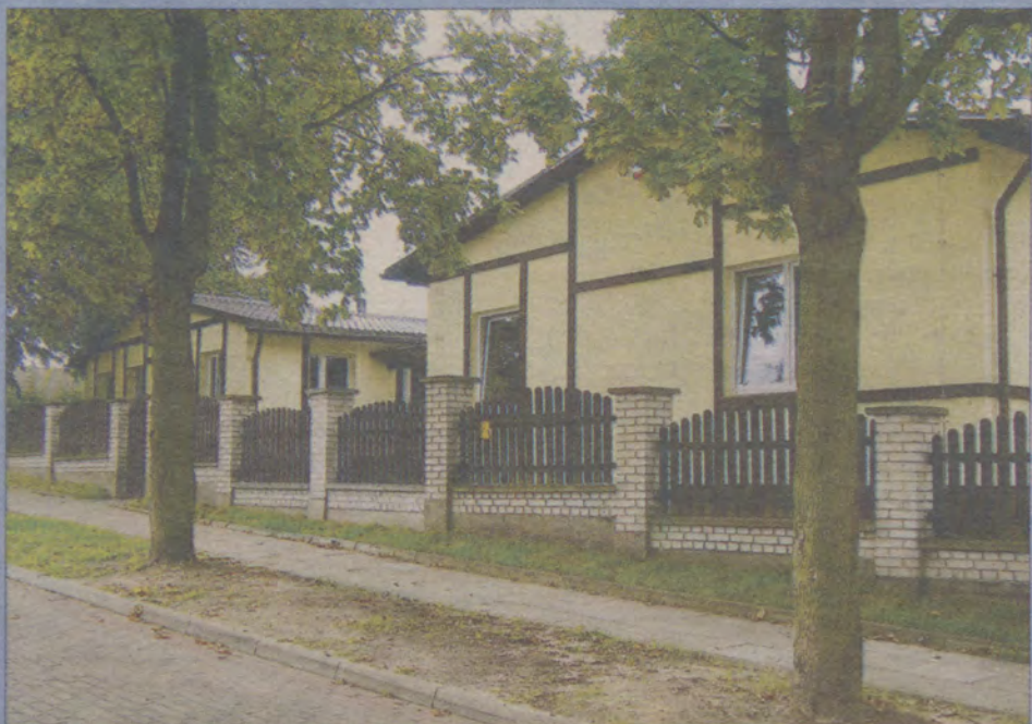
Tak wygląda ośrodek po przebudowie.
