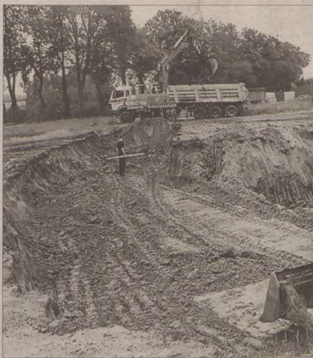
Prace ziemne przy ul. Zblewskiej już ruszyły.
