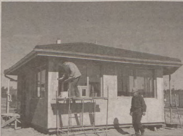
Składowisko ma zacząć działać na początku października. Na zdjęciu: budowa pomieszczenia, w którym ważone będą samochody zwożące śmieci.
