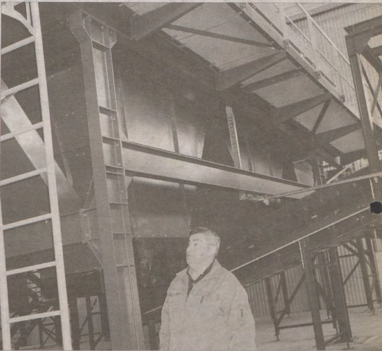
Sortownia to pierwsza wybudowana część powiatowego składowiska odpadów. Tam najpierw trafią śmieci. Na zdjęciu: Zenon Kościński, prezes Zakładu Utylizacji Odpadów w Kwidzynie.
