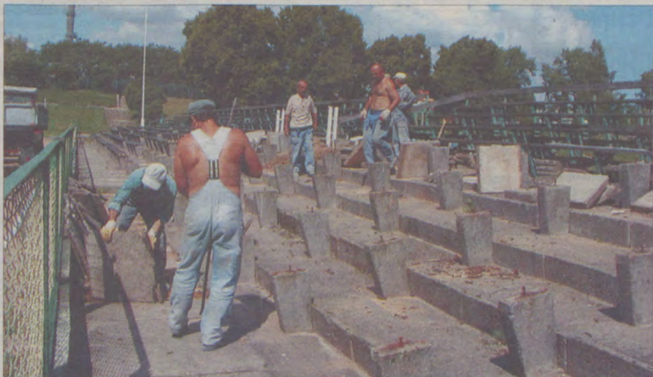
W stadion inwestowano już latem ubiegłego roku. W miejsce drewnianych ławek zamontowano dwieście plastikowych krzesełek dla kibiców. Wkrótce powstanie kolejnych trzysta.
