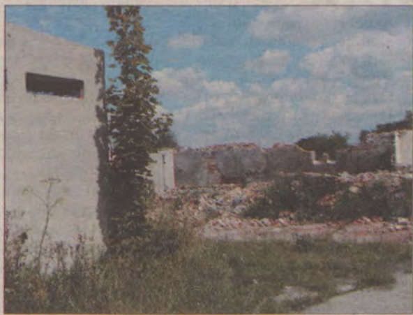
Z opuszczonego budynku stolarni w Czarnem Dolnym ukradziono już drzwi, okna, cegły...
