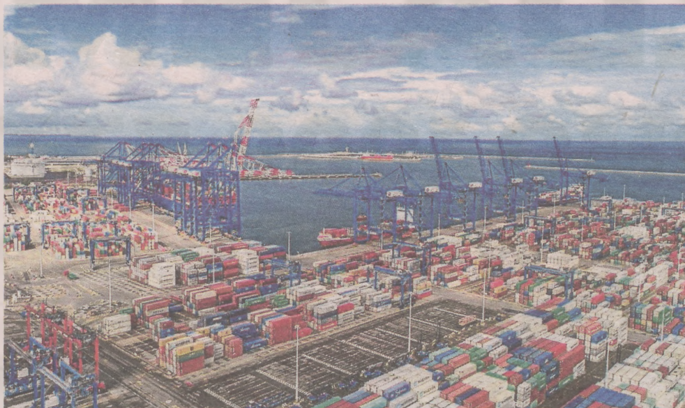
Dzięki rozbudowie o nowy terminal całkowita przepustowość portu w Gdańsku ma zwiększyć się o prawie 50 proc. do 2025 roku
