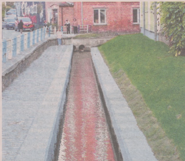
Rzeka Bytowa po regulacji w rejonie Bytowskiego Centrum Kultury
