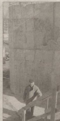
Ks. proboszcz Bogumił Nowakowski na budowie kościoła św. Karola Boromeusza w Wielkim Kacku.
