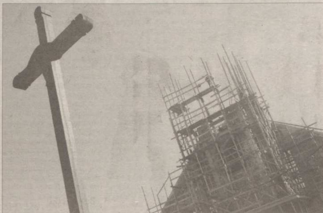
W tej chwili pokrywany jest dach kościoła św. Jadwigi Królowej na Karwinach.
