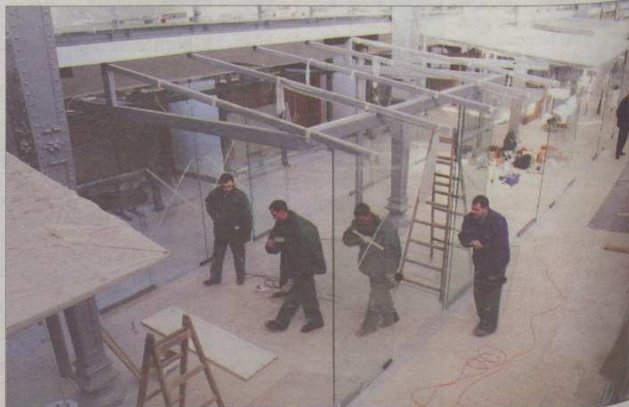
Prace w Hali Targowej trwają. Antresola jest już gotowa. Teraz ekipy remontowe ustawiają szklane ściany stoisk na parterze.
