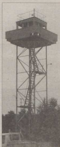
Ta wieżyczka przed laty służyła wartownikom do pilnowania granicy między NRD i RFN
