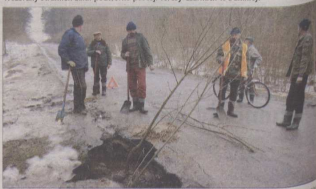
W Waplewie woda uszkodziła drogi.
