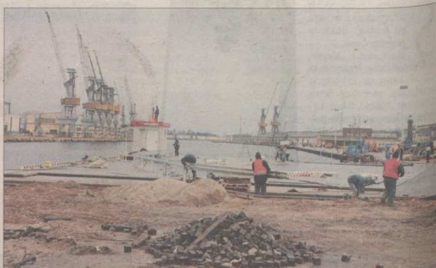
Zakończyła się odbudowa pierwszego odcinka nabrzeża WOC II w Wolnym Obszarze Celnym portu gdańskiego, a drugi zostanie odbudowany ze wsparciem funduszy unijnych.
