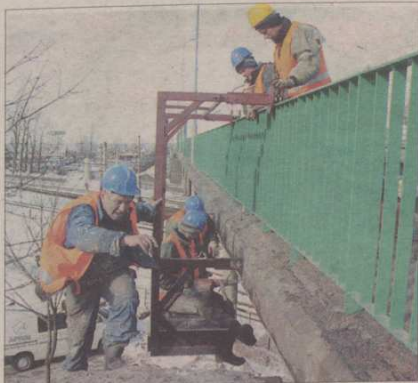
Wczoraj zabezpieczono torowisko pod wiaduktem, dzisiaj zamknięte zostaną dwa pasy ruchu w kierunku Gdyni.
