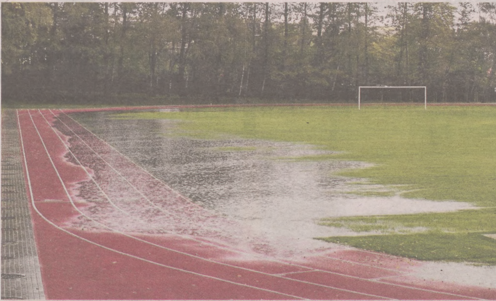
Niedziela, 2 października, godz. 14. Zalane boisko Zespołu Szkół Agrotechnicznych, pod którym jest nowy zbiornik retencyjny
