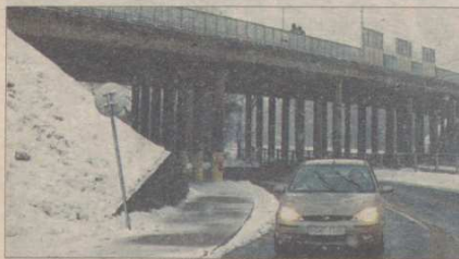
Wiaduktem trudno będzie przejechać do czerwca.
