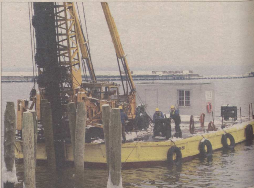
Kafar dźwiga tonowe bale jakby to były zapalki. Kilka uderzeń młota spalinowego i już pal tkwi w morskim dnie.
