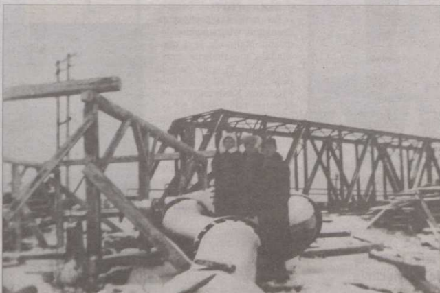
Rok 1945. Zniszczona pompa przy moście na Motławie.
