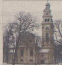
Elewacja kościoła Zbawiciela jest mocno zniszczona. Dzięki dotacji za kilka miesięcy ma wyglądać jak... nowa.
