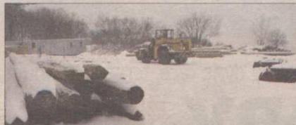
Zimowa aura nie sprzyja pracom przy remoncie mola. Wykonawca zapewnia jednak, że nie będzie opóźnienia.
