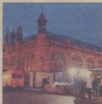
I handlowcy, i mieszkańcy Gdańska odliczają dni do końca remontu Hali Targowej.
