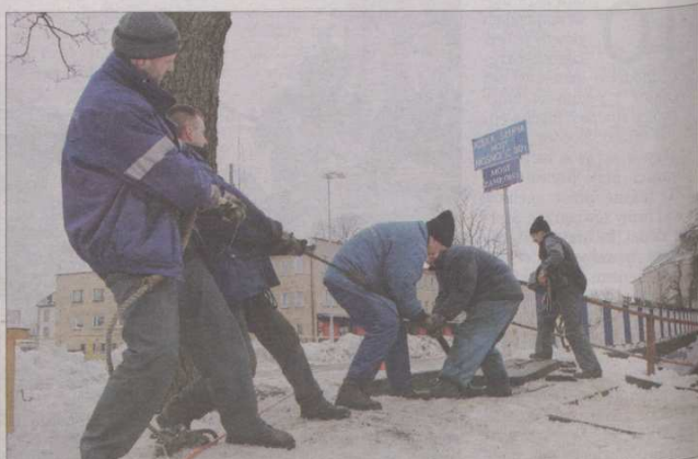
Złomiarze ukradli 200 metrów kabla z kanału komunikacyjnego pod mostem przy ul. Garnarskiej. Naprawa trwała dwa dni.
