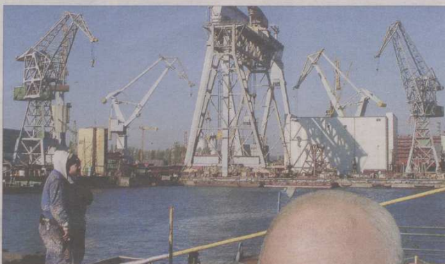
Prokuratura zajmuje się sprawą niekorzystnych kontraktów, które miał zawierać zarząd stoczni. W śledztwie pojawia się nazwisko kontrowersyjnego biznesmena z Izraela - Ramiego Ungara.
