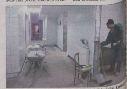
Na obiekcie MOSiR przy ulicy Traugutta w Gdańsku kończy się remont szatni.
