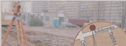
Na budowę parkingu nie godziła się spora część mieszkańców.
