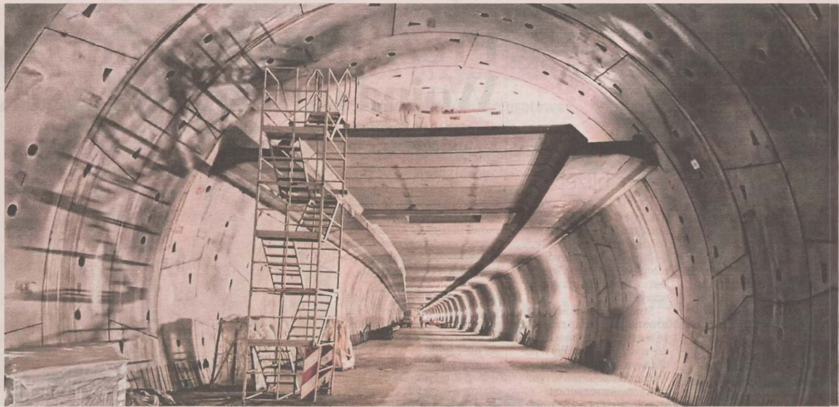
Tunel pod Świną będzie najdłuższą podwodną przeprawą w Polsce. Długość tunelu i dróg dojazdowych to prawie 3,2 km, a samego tunelu 1,5 km
