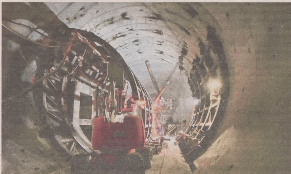
FOT. CEZARY IWANOWSKI, PORR S.A.
