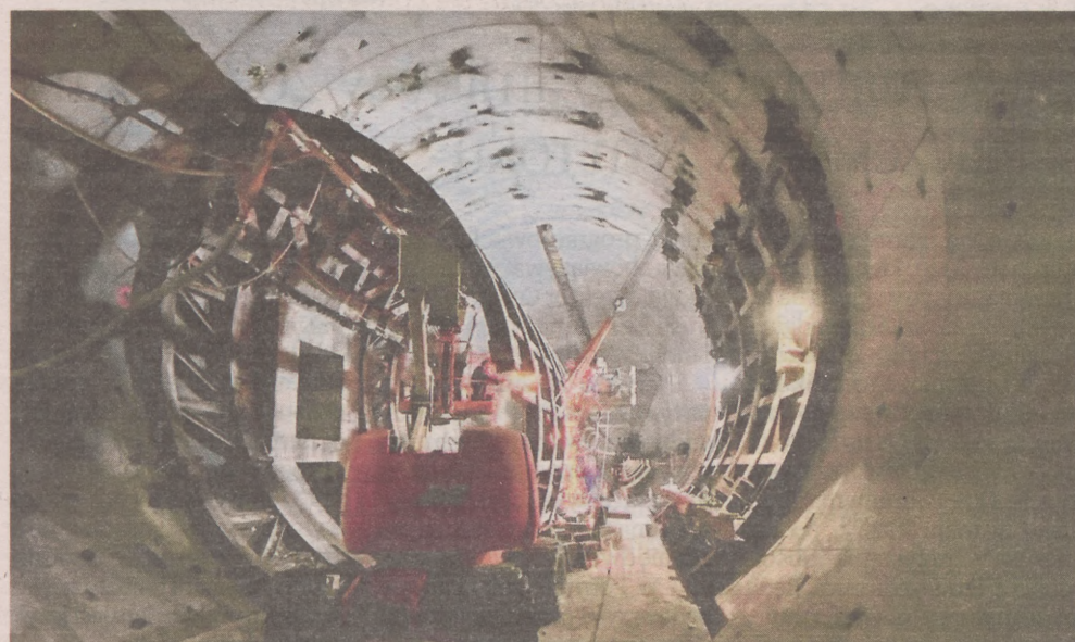
FOT. CEZARY IWANOWSKI, PORR S.A.
