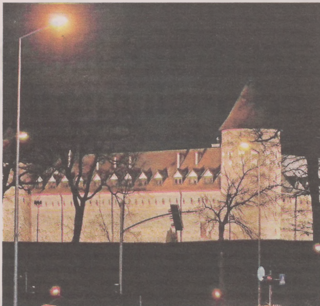
Zamek krzyżacki w Bytowie. Niebawem po zmroku zabytek będzie podświetlany tylko do godz. 22
