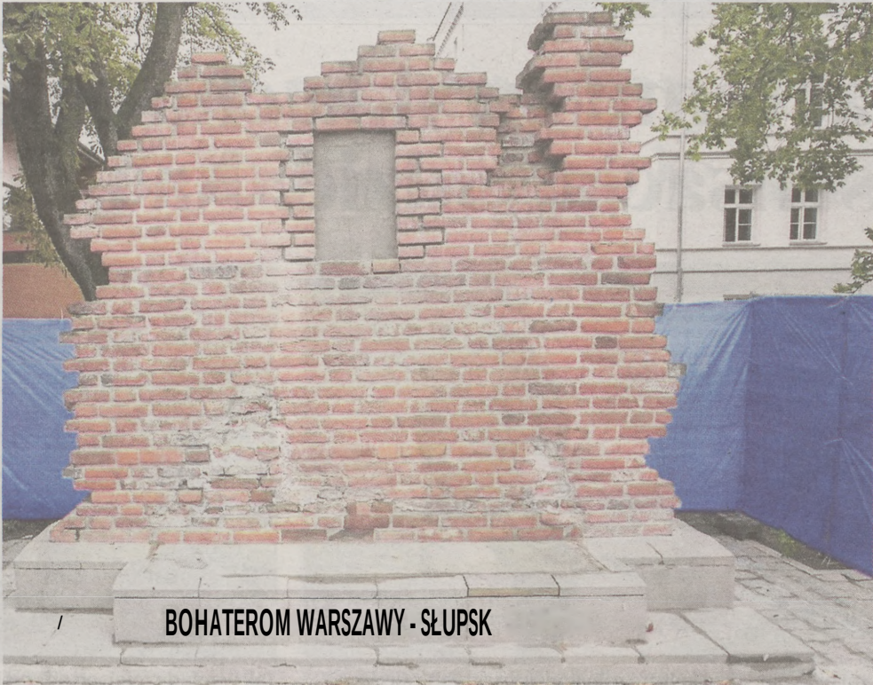
Pomnik Powstańców Warszawskich w Słupsku. Postać powstańca, pochylający się nad nim orzeł i tablica z herbem Warszawy już zostały zdemontowane do renowacji
