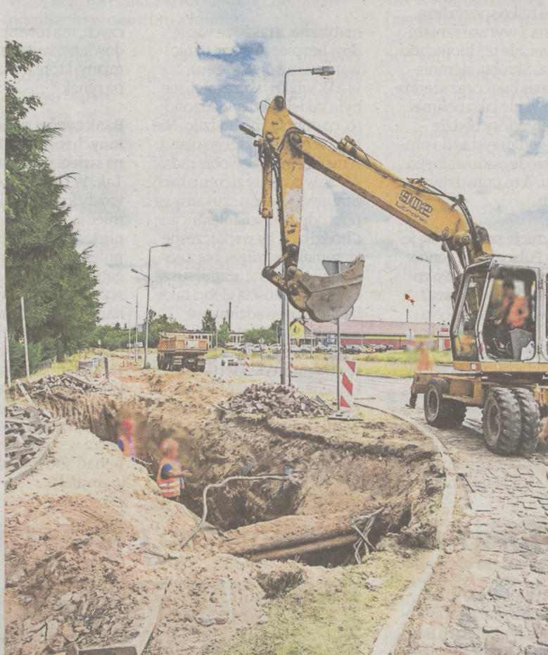
Końcowe prace ziemne podczas budowy słupskiego ringu w 2015 roku
