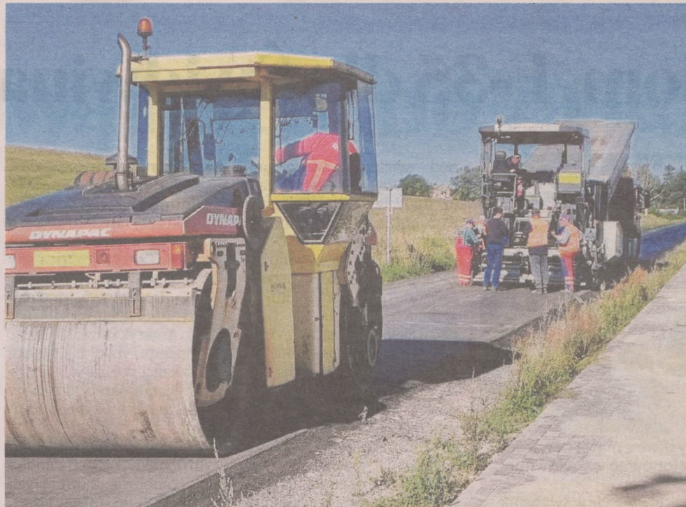
Prace przy przebudowie dróg łączących trzy gminy: Lipnica, Tuchomie, Borzytuchom. Inwestycja otrzymała dofinansowanie z Polskiego Ładu
