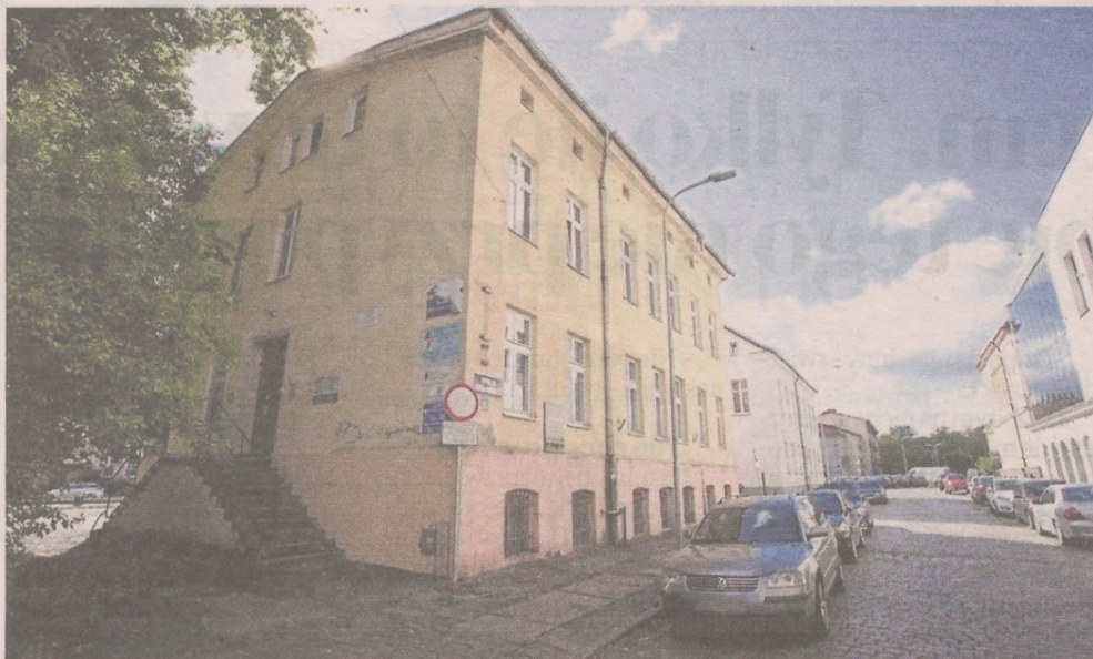
Kamienica przy ulicy Lutosławskiego 33 w Słupsku ma zostać wyburzona
