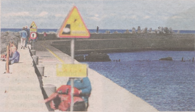
Zachodni falochron w porcie w Ustce. To z tej budowli spadła pani Agnieszka z Rybnika
