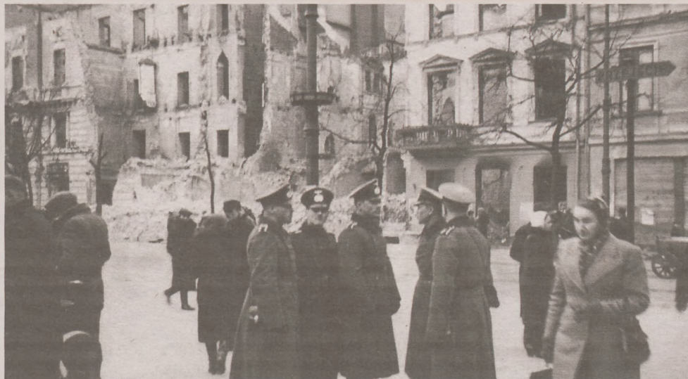
Oficerowie Wehrmachtu na tle zniszczonych kamienic w Warszawie jesienią 1939 roku
