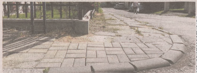
Narożnik chodnika kilka dni temu, już po naprawie
