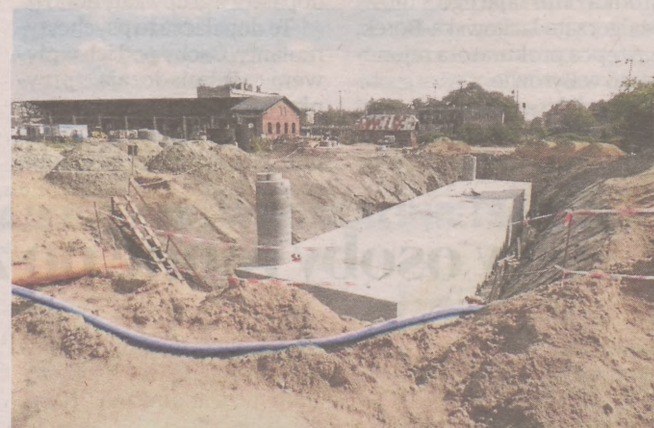
Zbiornik retencyjny będzie pod parkingiem
