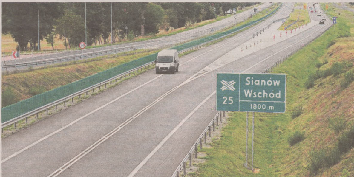
Droga krajowa nr 6 w pobliżu Sianowa. Tutaj trwają prace na budowie obwodnicy tego miasta
