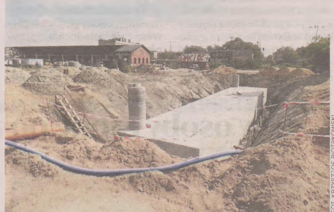
Zbiornik retencyjny będzie pod parkingiem
