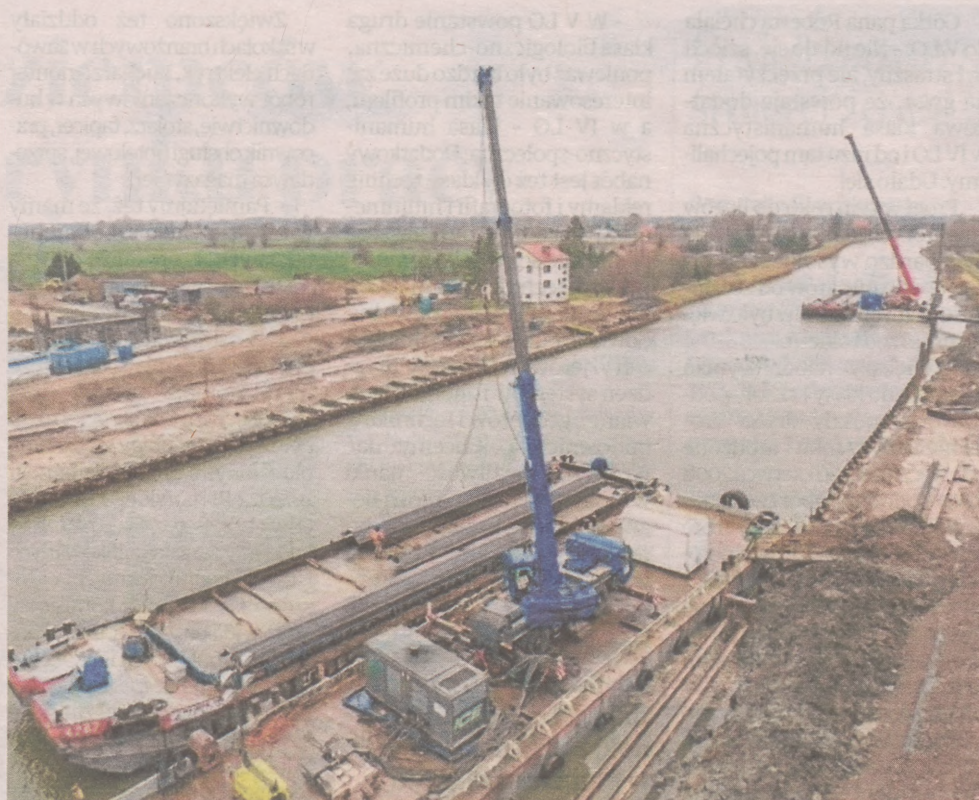
W tej chwili na budowie pracuje ok. 200 ludzi i 20 jednostek pływających
