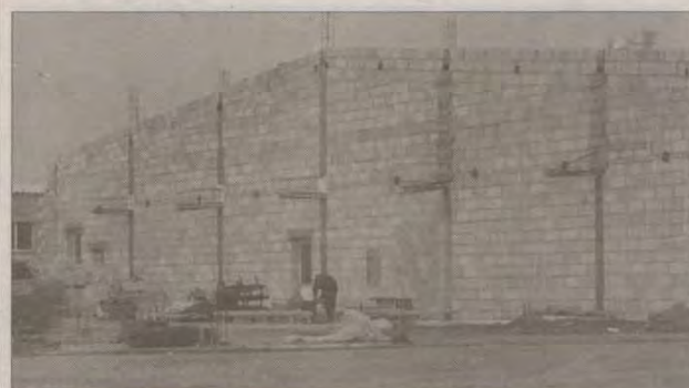
Na zdjęciu: hala w Zagórkach w trakcie budowy. Fot. S. Gliwka
