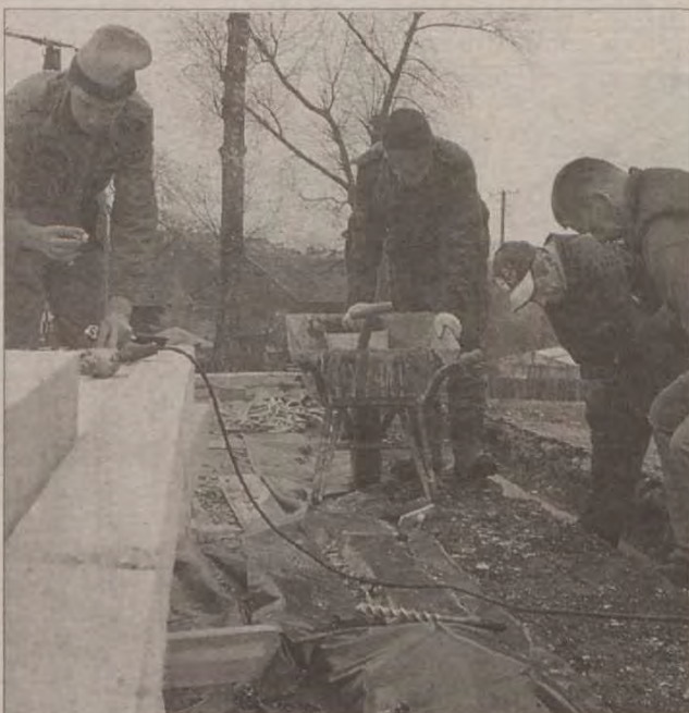
Remont dachu rzeczenickiej strażnicy robią sami strażacy. Fot. Piotr Furtak
