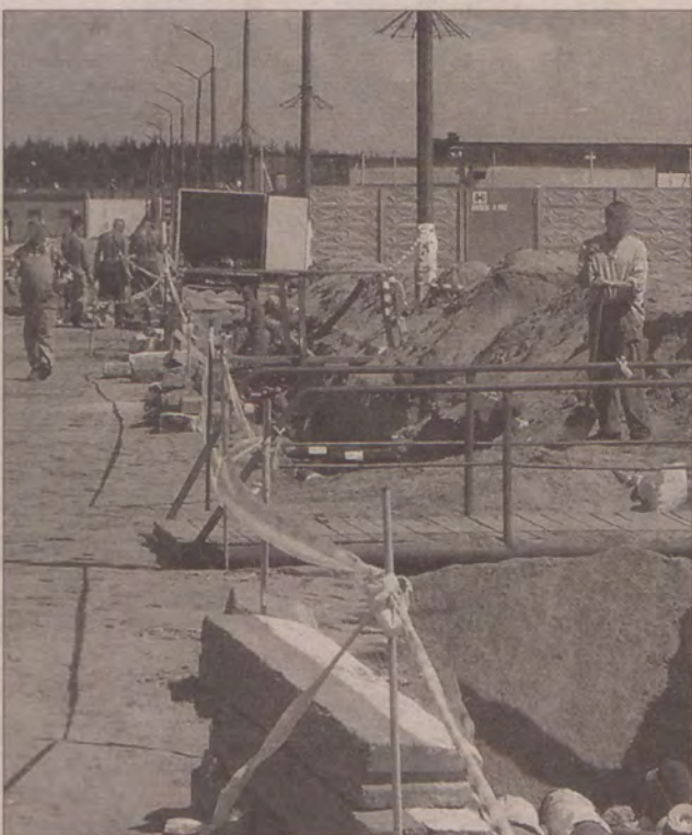
Więźniowie pracują w drukarni, ale również przy pracach porządkowych jak i więziennych inwestycjach. Na zdjęciu podczas modernizacji ciepłociągu.
