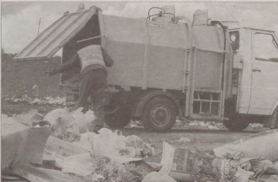
Wysypisko śmieci w Kiełpinie funkcjonuje od kilku lat. Jeśli nie powstanie zakład zagospodarowania odpadów, w niezbyt odległej przyszłości lat konieczne będzie budowanie drugiej niecki.
