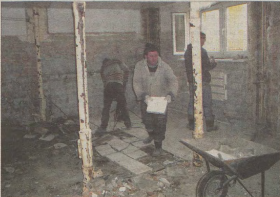
Trwa remont pomieszczeń na parterze bursy.
