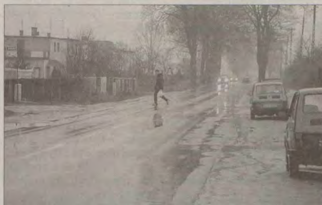
Modernizacja ul. Bytowskiej w Chojnicach to jeden z projektów, który chce zrealizować gmina Chojnice.
