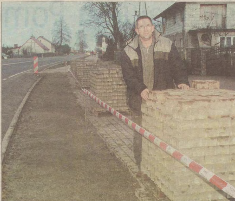
- Po co poprawiać coś, co istnieje od lat i spełnia swoją rolę? - zastanawia się Dariusz Kręski z Rytle stojąc przy rozbieranej właśnie nawierzchni parkingu.
