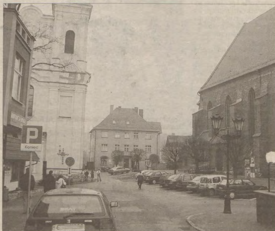
Już wkrótce szara ulica Gimnazjalna będzie równie barwna jak Stary Rynek. Blasku nabierze też zniszczona elewacja kościoła gimnazjalnego.
