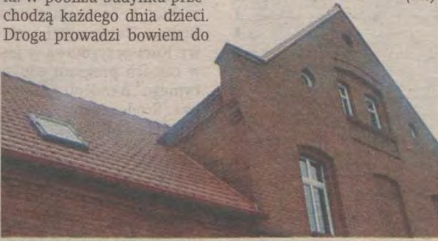
Już nic nie zagraża dzieciom przechodzącym nieopodal starego budynku szkoły. Zakończyła się bowiem wymiana okien i dachu.
