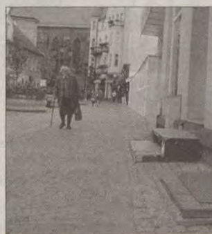
Na zdjęciu widoczny jest podniesiony próg wokół okna piwnicy.
