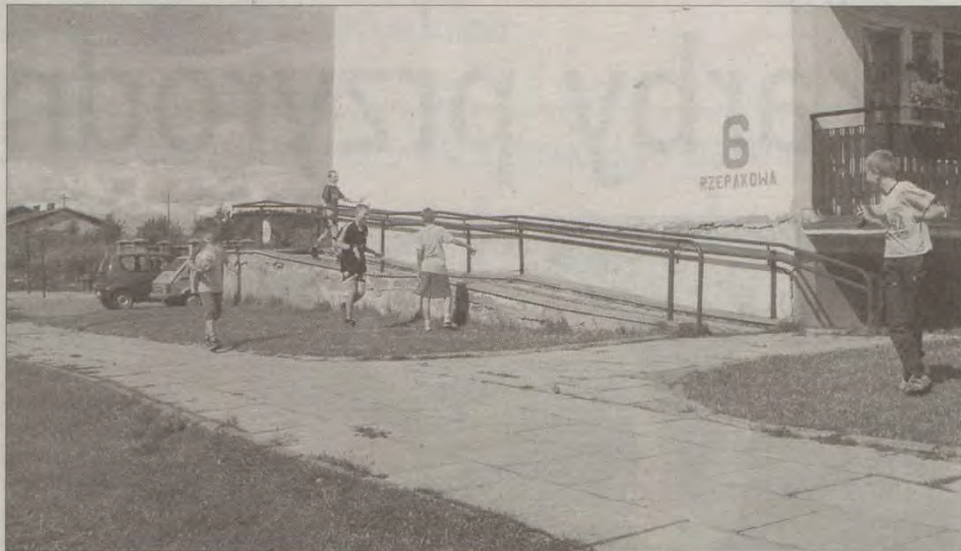
Jednym z udogodnień dla niepełnosprawnych ruchowo, zastosowanych w bloku przy ul. Rzepakowej w Chojnicach, są podjazdy i osobne wejścia na klatkę schodową.
