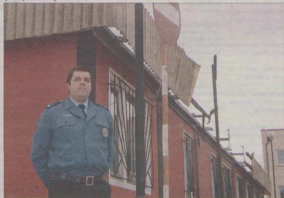
Barak przez 13 lat użytkowania stracił nieco na wartości. Ostatnia wichura uszkodziła dach.
