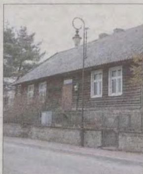
Od kwietnia budynek szkoły w Swornegaciach będzie starannie przebudowywany.
