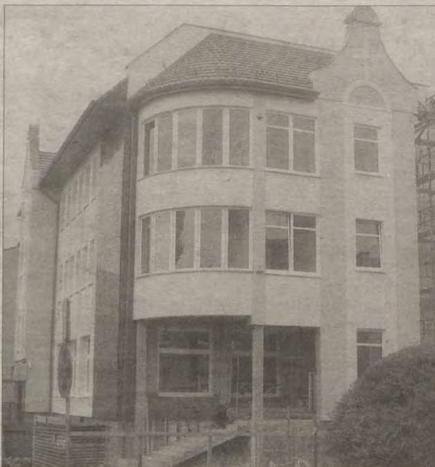
Tak bank wygląda teraz, na kilka miesięcy przed zakończeniem przebudowy. Wielkie zmiany widać już teraz.
