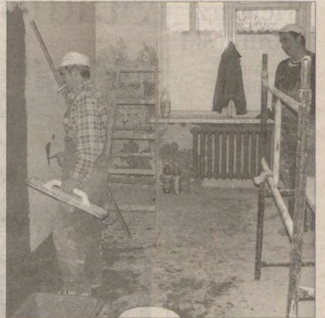
Trwają prace przy modernizacji parteru internatu.
