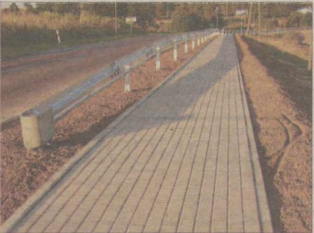
Niebawem ukończony zostanie chodnik na ulicy Kowalskiej w kierunku skrzyżowania na Świeszyno.
