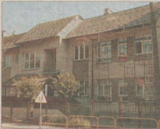
Na Przedszkolu nr 1 blachodachówkę kładzie firma Stefana Filarskiego z Miastka.
