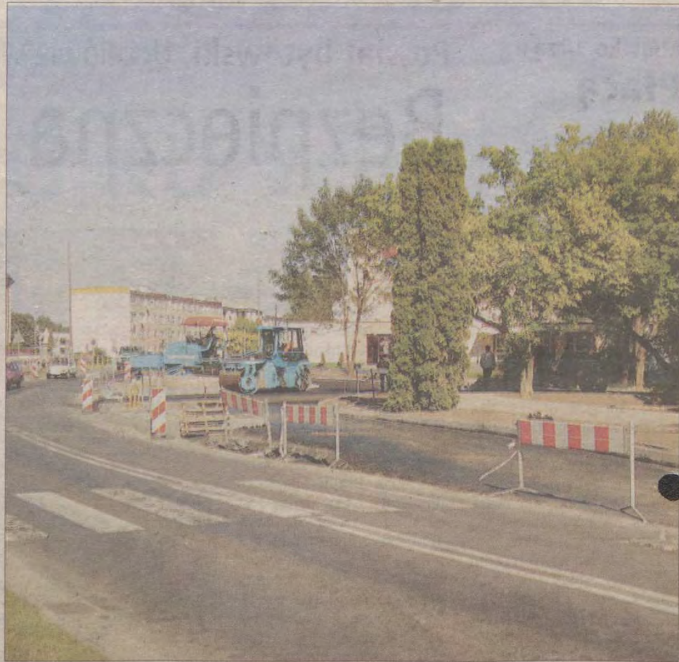
Cały czas trwa budowa ronda. Inwestycję realizuje GDDKiA. Prace potrwać do 15 września.
