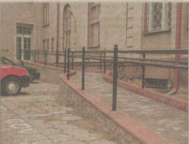
Pracownicy interwencyjni za 20 tysięcy złotych wykonali podjazd dla niepełnosprawnych na parkingu za ratuszem. Zamontowano też rozsuwane drzwi.
