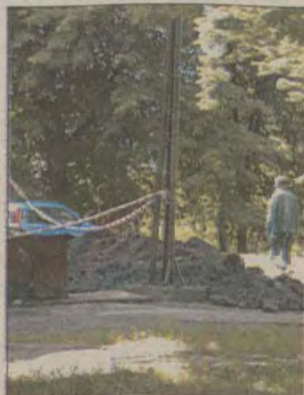
Remont kotłowni w szpitalu ruszył pełną parą.
