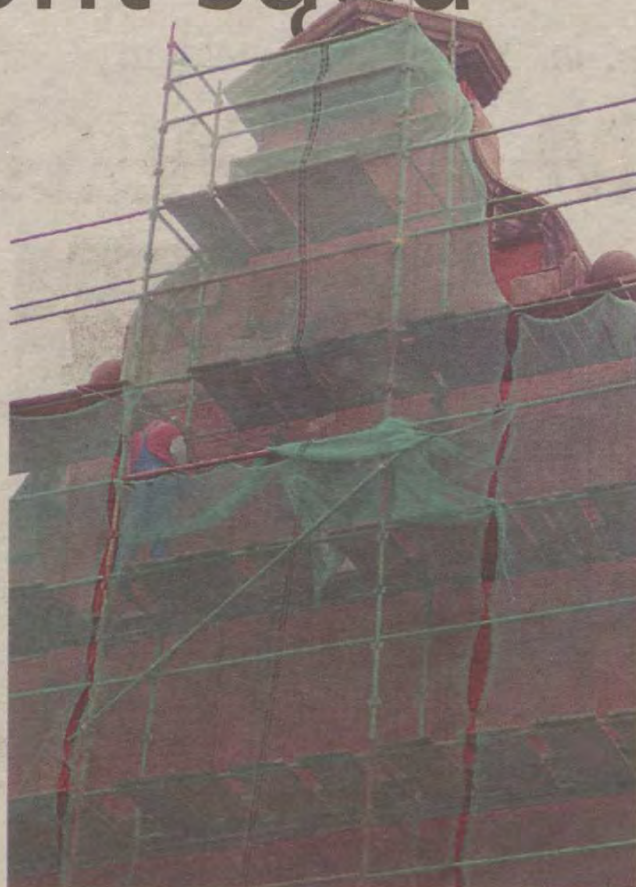
Ściana frontowa Sądu Rejonowego w Miastku jest naprawiana po uszkodzeniach sprzed 60 lat.
