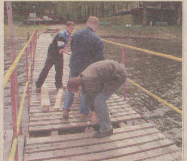
Prace porządkowe rozpoczęły się od pomostu, w którym trzeba wymienić deski.
