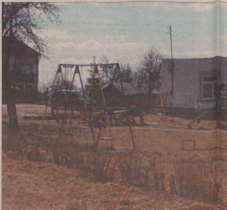
Świećlica w Ząbinowicach zostanie przebudowana.
